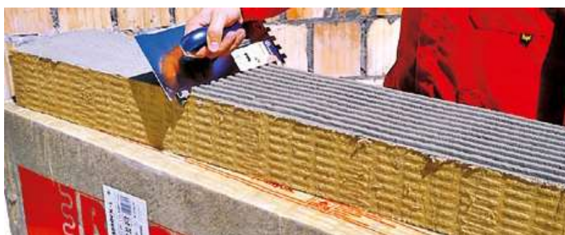
Obr. 4: Celoplošné nanášení lepicí hmoty
